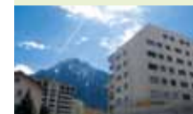
Eine clevere Lösung Anergienetz Naters – Grundwasser als Wärmequelle
